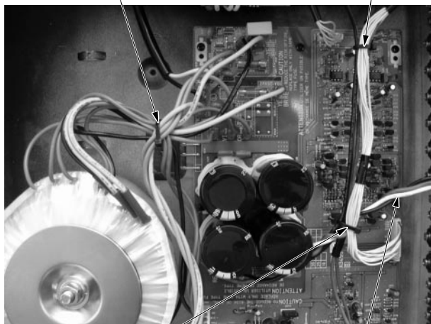
Bundle by cord holder. (インシュロックタイで束ねます。) (WA010800, WA010900, WA01130, WA01140, WA01150, WA01160)
